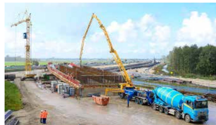
Betonwerkzaamheden Knoppunt Hofvliet. (Beeld: Rick Keus)
