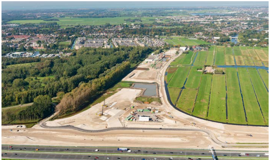
Luchtfoto van het gebied startschacht (A4-zijde) en omgeving.
