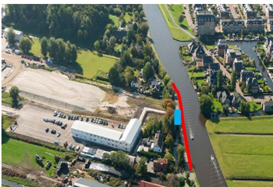
Rood: deel waar de oeverconstructie wordt vervangen. Op het blauwe vlak (thv nr 90) wordt ook onder de weg gewerkt.
