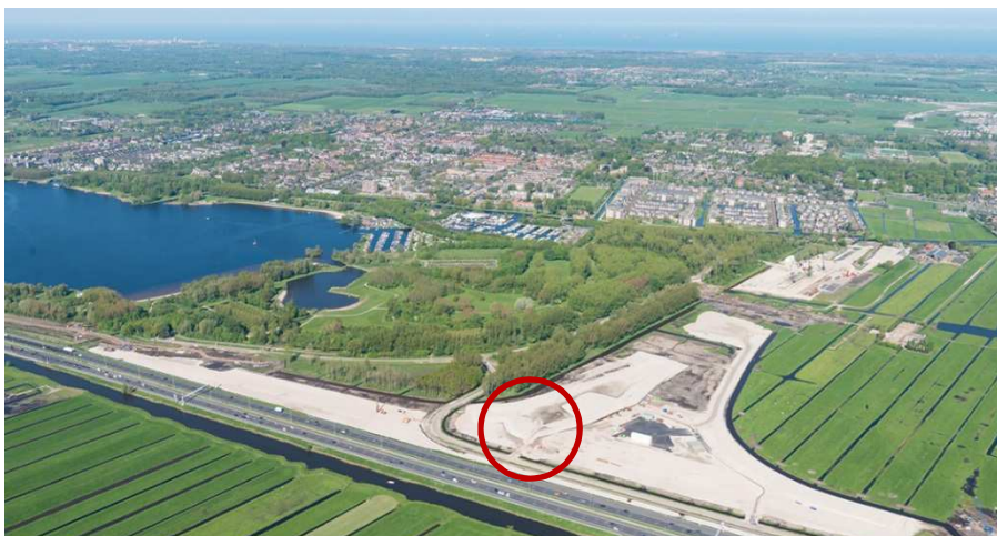
Locatie heiwerkzaamheden knooppunt Hofvliet
